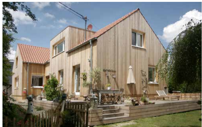
Häuser in Holzbauweise sind nicht nur klimafreundlicher, sondern machen auch optisch eine Menge her.
